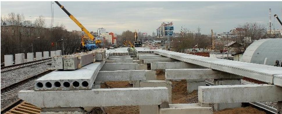
*Перед началом монтажа краевых балок ТЖБИ-4 на станции Измайлово, МКЖД*
