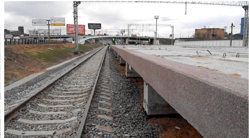
*Смонтированная краевая балка ТЖБИ-4 из бетона со вскрытой поверхностью на станции Автозаводская, МКЖД*
